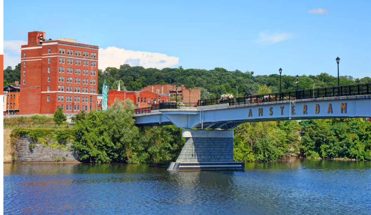
Mohawk tire son nom de la rivière Mohawk, le plus grand affluent de l'Hudson, dans le nord de l'État de New York. Les installations d'origine de la société ont été construites à Amsterdam, dans l'État de New York, des deux côtés de la rivière Mohawk. La rivière fournissait de l'énergie hydroélectrique, de l'eau à des fins de fabrication et un moyen de transport de marchandises vers les principaux centres via l'Hudson et le canal Érié.
